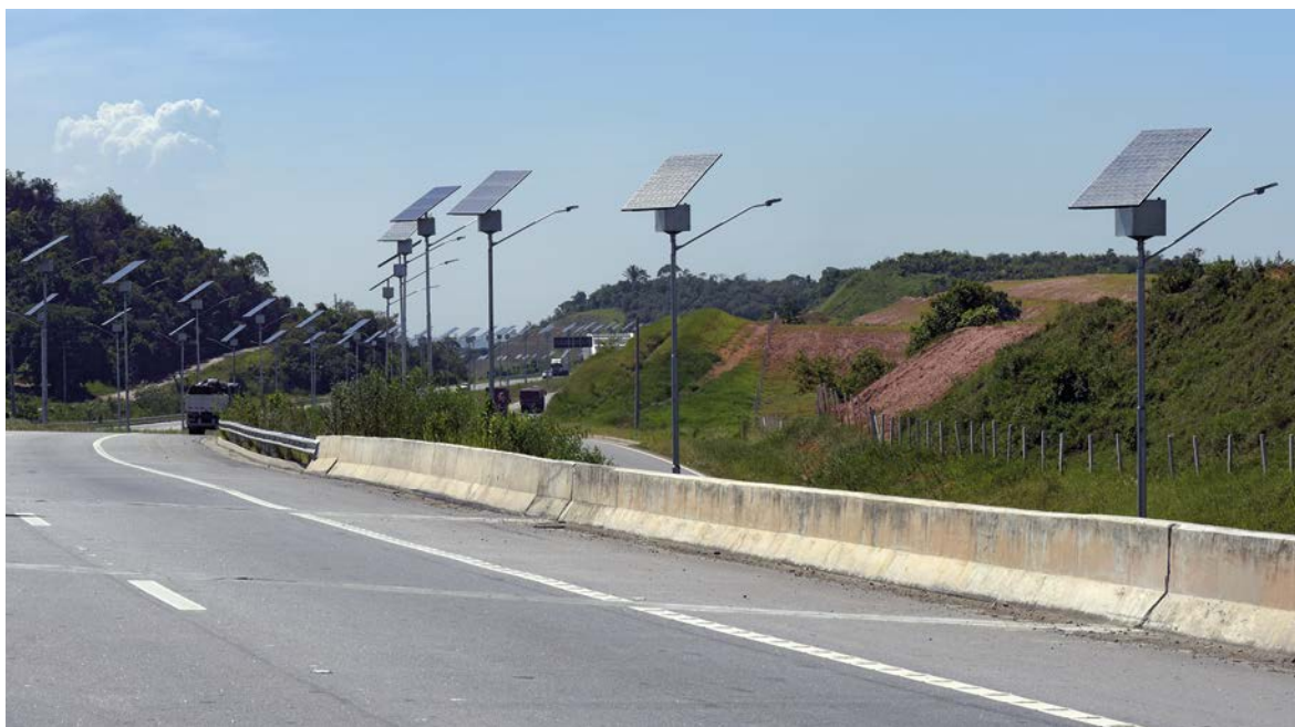
Paneles solares utilizados para iluminación de carretera en el Anillo Metropolitano de Río de Janeiro
